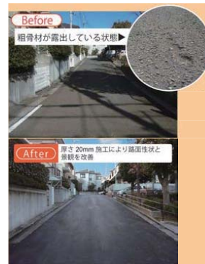
■ 路面のリフレッシュ（生活道路）
