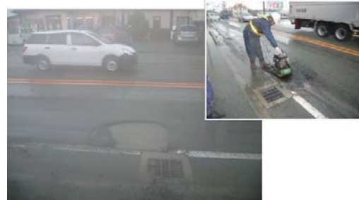
■ 「マイルドパッチ」施工状況（水溜り箇所）
