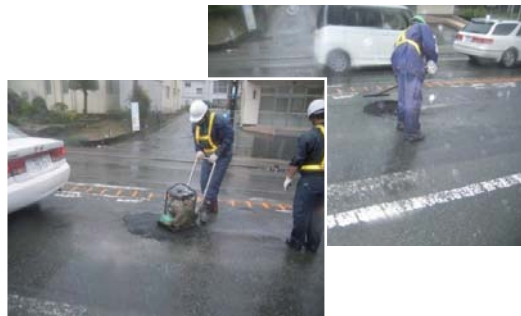
■ 「マイルドパッチ」施工状況（雨天時）
