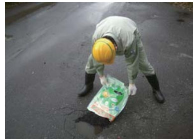
■ 「マイルドパッチ」施工状況
