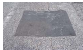
物流センター 施工後2年
