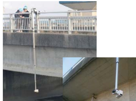
高欄より懸垂した橋梁点検ロボットカメラ
