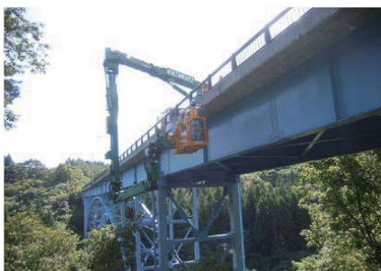
写-1 橋梁点検車による点検状況
