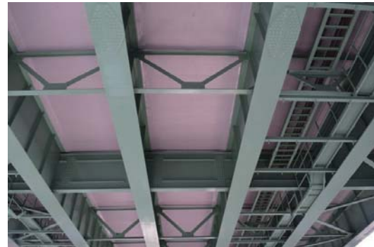
シートによる補強面(仕上げ塗装後)
