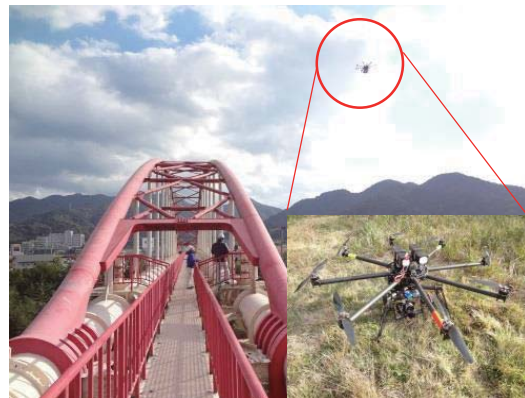
写真-3 マルチコプターによる点検
