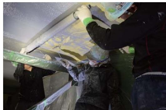
樹脂を事前含浸した繊維シートの貼付け状況
