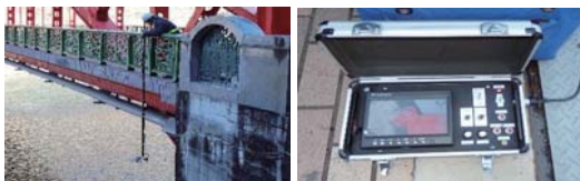
写真-1 ポールカメラによる点検
