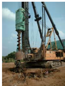
リフューズプレス工法
