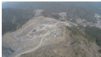
碎石場の定期土量管理をするため、測量を実施。大規模な土地も1日で測量を終えることができる
