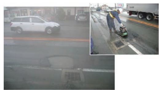
■ 「マイルドパッチ」施工状況（水溜り箇所）
