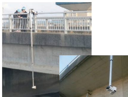
高欄より懸垂した橋梁点検ロボットカメラ
