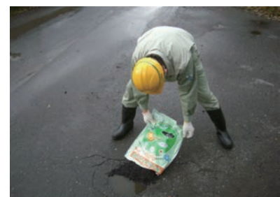
■ 「マイルドパッチ」施工状況
