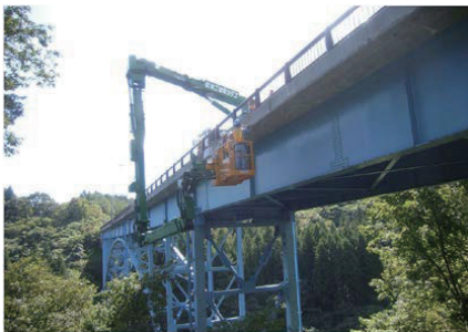
写-1 橋梁点検車による点検状況
