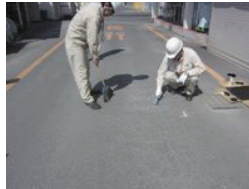
③既設路面の清掃
