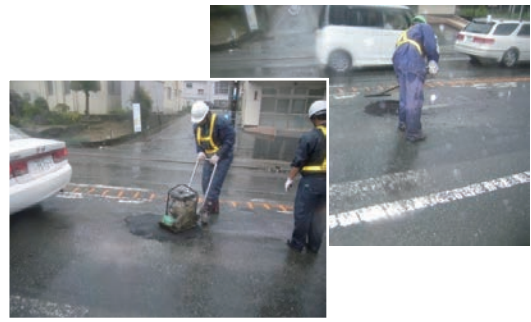
■ 「マイルドパッチ」施工状況（雨天時）
