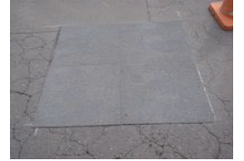
⑥貼付け完了
