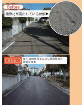
■ 路面のリフレッシュ（生活道路）
