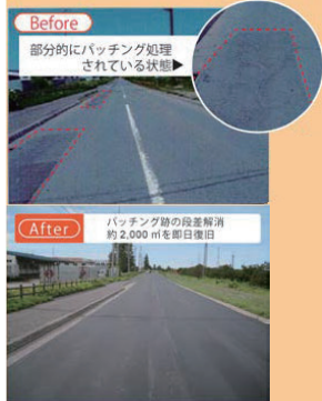
■ パッチング、ひび割れの補修（幹線道路）
