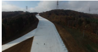
スキー場(スノーマットの)のゲレンデの状況を空撮。高低差を苦としない
