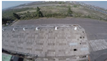
工場屋根の破損状況を把握するための空撮。上空から見ることで漏水原因や劣化箇所を見ることができる
