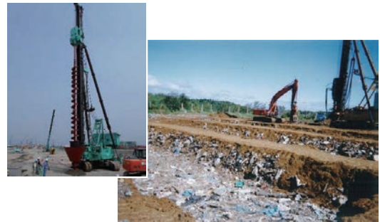
減容化事例（沈下量：1.17m 減容率：23.4%）
