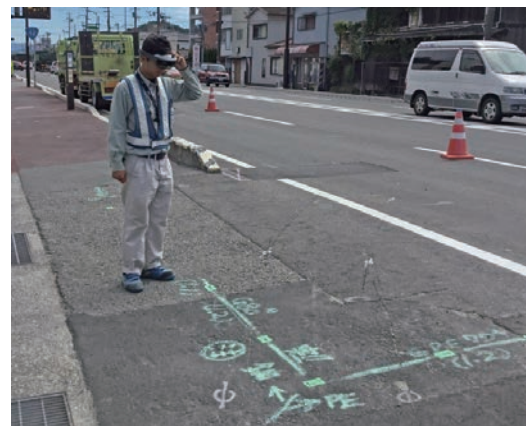
HoloLensによる埋設管の確認状況
