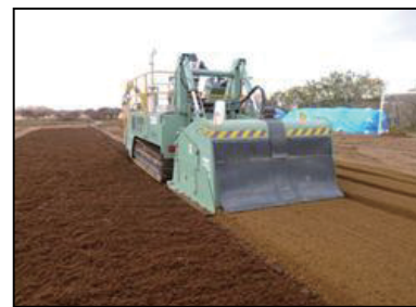
ストーンセパレータによる混合状況
