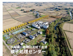
秋田湾・雄物川流域下水道 横手処理センター 1989供用 処理能力24.6千m 3 /日 ポンプ場7(MP含)
