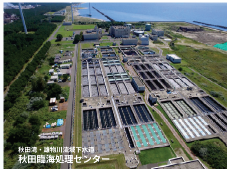
秋田湾・雄物川流域下水道 秋田臨海処理センター 1982供用 処理能力143千m 3 /日 ポンプ場28(MP含)
