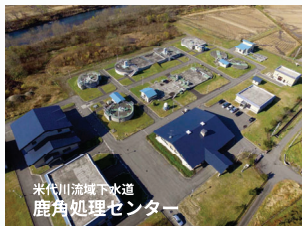
米代川流域下水道 鹿角処理センター 1995供用 処理能力8.2千m 3 /日 ポンプ場4(MP含)
