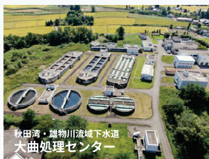
秋田湾・雄物川流域下水道 大曲処理センター 1988供用 処理能力16.2千m 3 /日 ポンプ場9(MP含)
