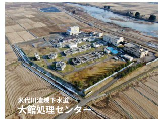
米代川流域下水道 大館処理センター 1992供用 処理能力15千m 3 /日 ポンプ場9(MP含)
