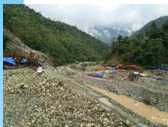
1. 工事風景 (2015年7月撮影)
