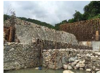
3. 取水堰工事風景 (2015年7月撮影)
