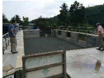
2. 一次濾過施設（沈砂池） (2015年7月撮影)
