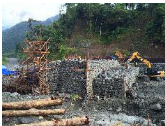
2. 取水堰工事風景 (2015年7月撮影)
