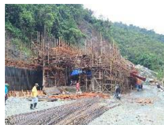
3. 沈砂池工事風景 (2015年7月撮影)
