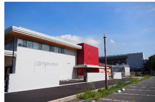
隣接する浄水場・給食センター
