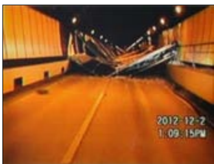
笹子トンネル天井版崩落事故(2011)
