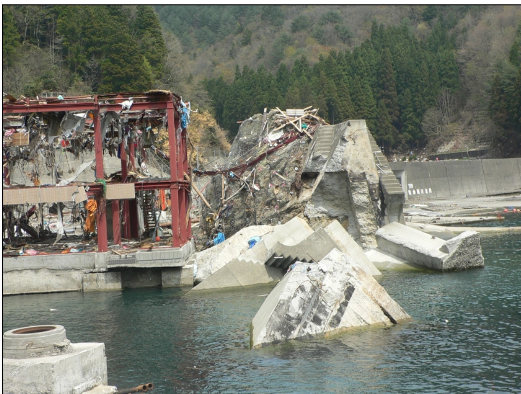
10mの防波堤が完全に破壊されている（釜石市両石）
