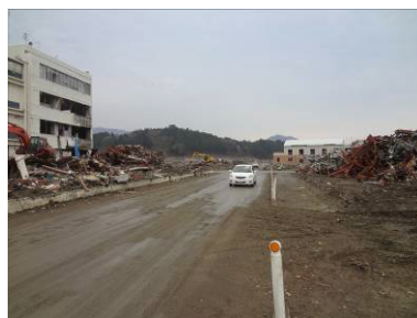
周辺部は瓦礫が残り、建物はなくなっていた
