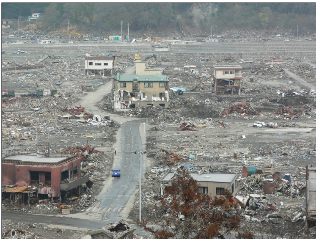
津波により町が壊滅 (大槌町)
