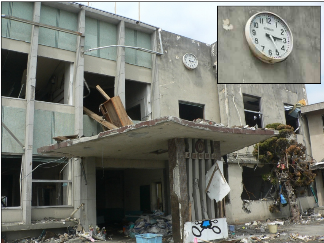
津波により役場機能が壊滅（大槌町）
