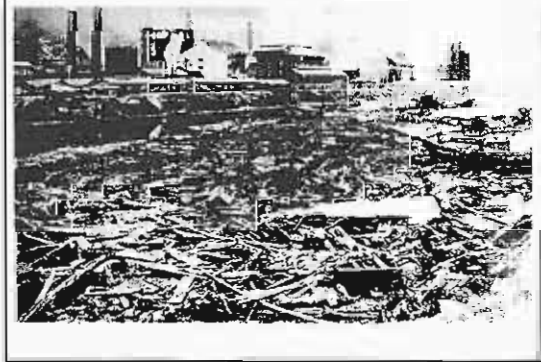
図表Ⅱ－13 昭和三陸地震津波 釜石港の様子
