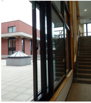
前川本館二重サッシ室内側から撮影 前川本館外壁側から撮影
