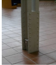
鉄骨柱床立上げ部
