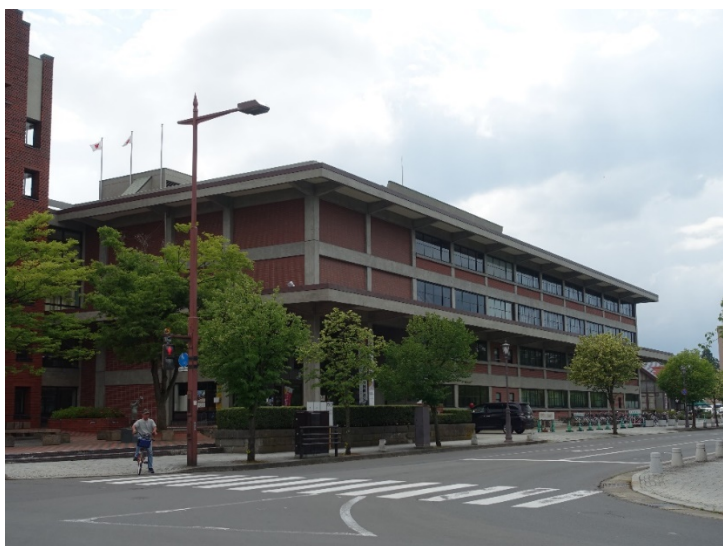
弘前市庁舎前川本館（既存建物竣工年 1958年）
