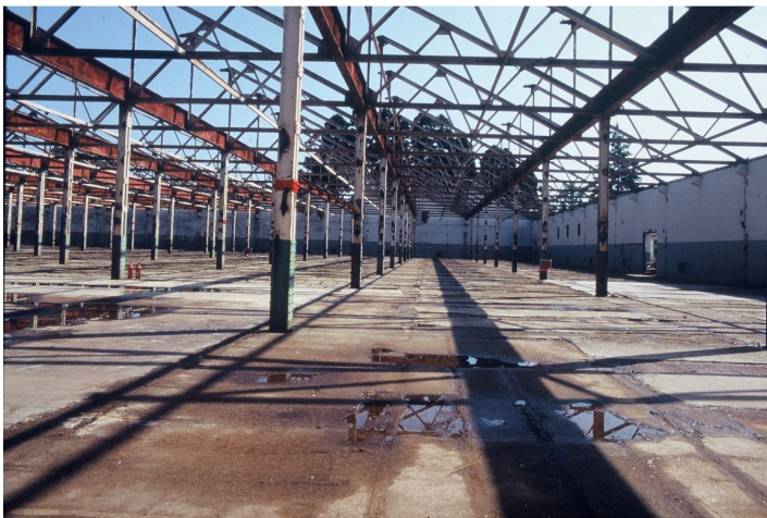
大規模改修工事に利用された建築部位
