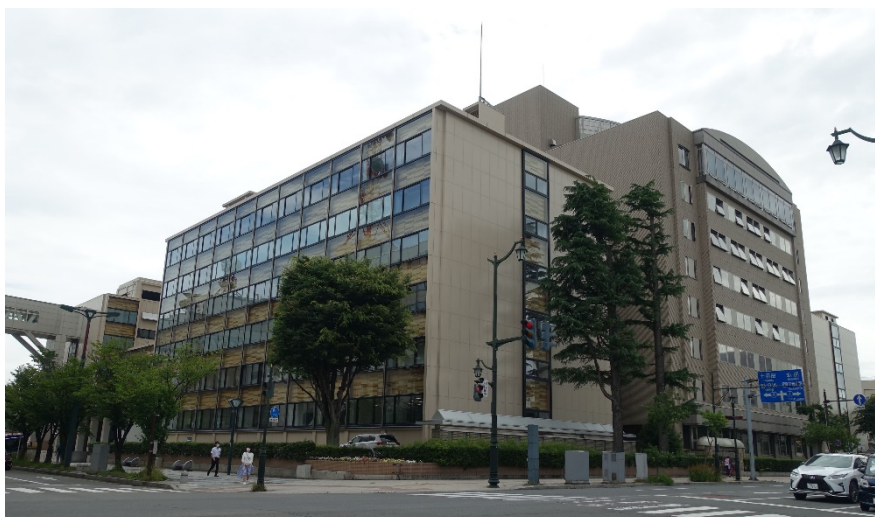
青森県庁舎議会棟・西棟（議会棟既存建物竣工年：1960年）2018年改修オープン
