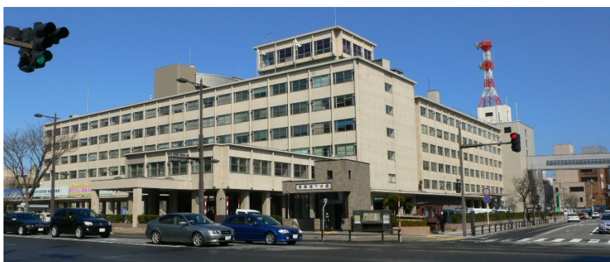
青森県庁舎南棟・東棟 地上8階建の改修前の外観写真
