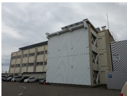
旧特別教室棟(竣工年：1966年)
