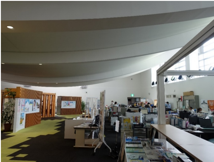
旧第2体育館 2階執務室（新設された舟形天井：テント膜張り）
