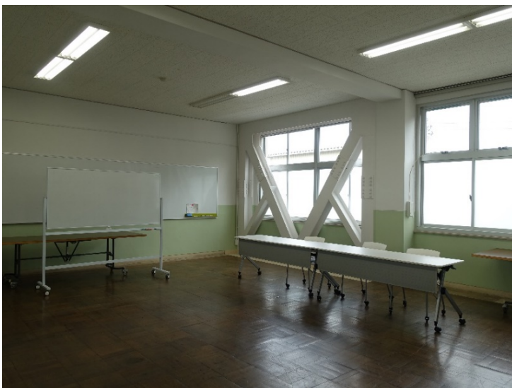
耐震補強を施し、既存教室のレイアウトを再利用
