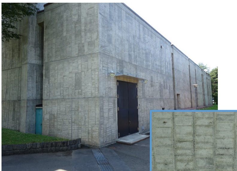
外壁改修後のコンクリート打ち放し バラ板型枠のコーラージュ
